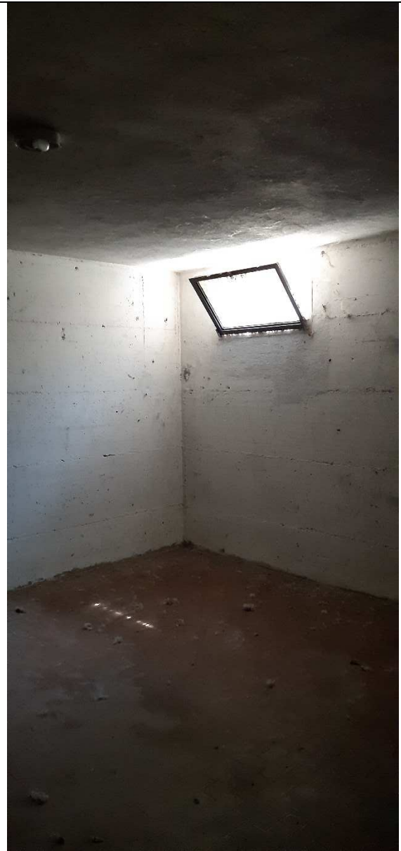
Figura 28 - locale piano interrato
